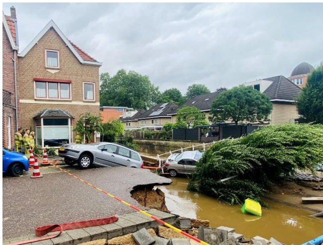
Afbeelding 2 Sinkhole en schade
